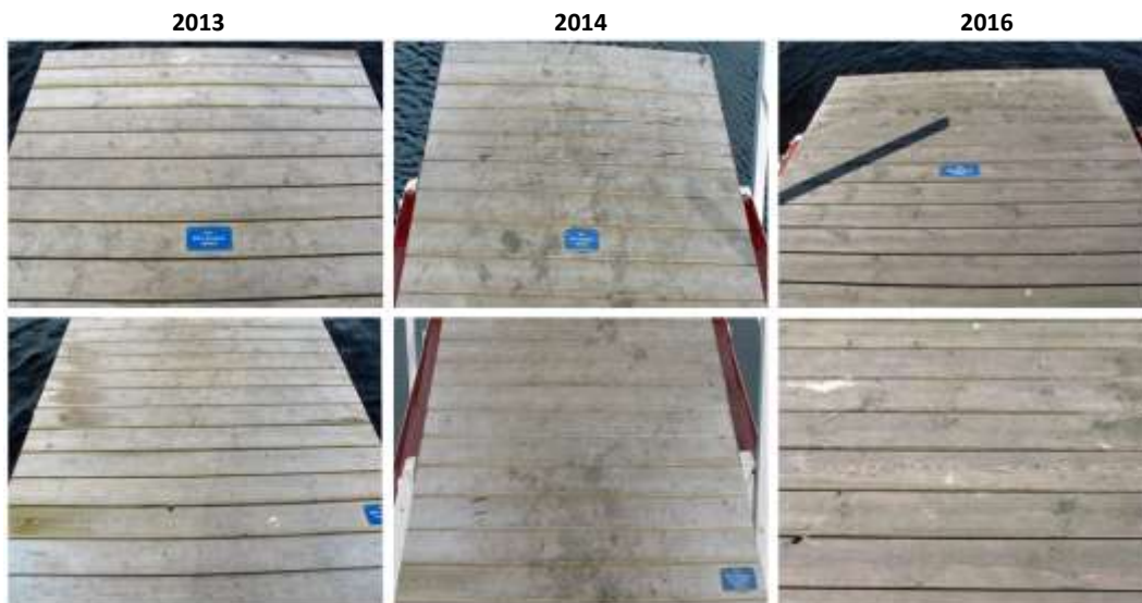
Figur 8. Jämförande foton över impregnerat trä vid olika inspektionstillfällen.
