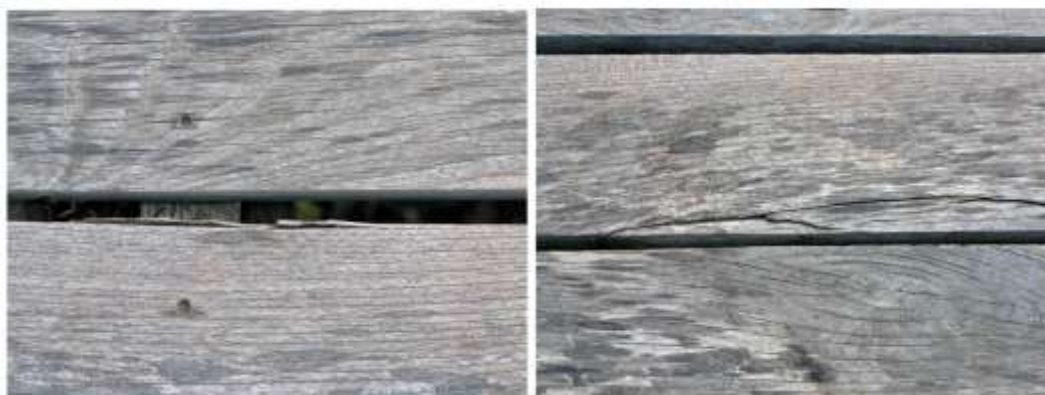
Figur 18. Närbilder av robinia från senaste inspektionstillfället.
